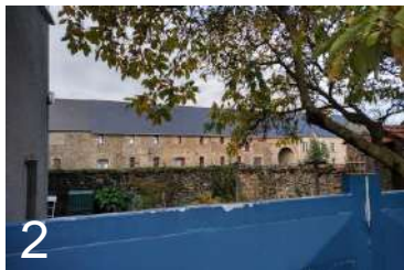
2 UDAP de la Manche, ferme sur la RD34- 2022
