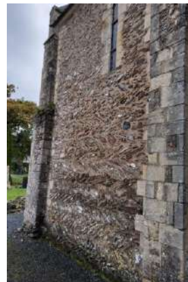
UDAP de la Manche, l'église Saint-Ebremond, détail des maçonneries en écailles de poisson - 2022
