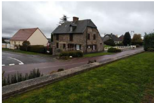
©UDAP de la Manche, pavillon et construction traditionnelle pris depuis la place de l'église - 2022
