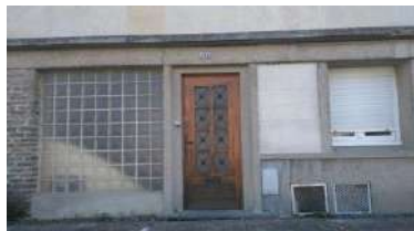
UDAP de la Manche - pavé verre - détails reconstruction - rue Marechal Leclerc, Saint-Lô - 2023
